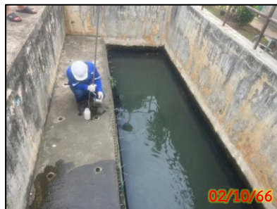
จุดเก็บตัวอย่างน้ำเสียก่อนเข้าสู่ระบบบำบัดน้ำเสีย
