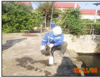
จุดเก็บตัวอย่างน้ำเสียก่อนเข้าสู่ระบบบำบัดน้ำเสีย
